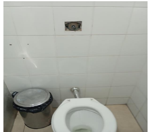
Conserto de vazamento da válvula de descarga
