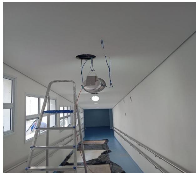
Circuito elétrico e troca de cabos
